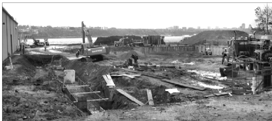
Construction du nouveau centre sportif. État du chantier le 26 octobre 2010.
